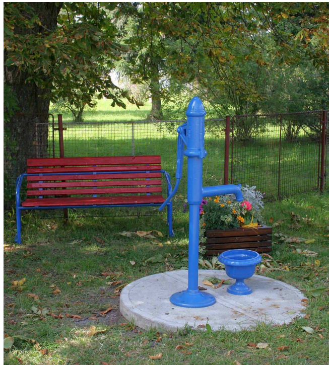
Obr. 1.3. Domovní studna s klasickou ruční pumpou
